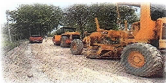
งานก่อสร้างถนนคอนกรีต เสริมเหล็กสาย หมู่ ๘ บ้านอุทัย
