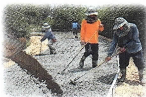
ก่อสร้างถนนคอนกรีต เสริมเหล็กสาย หมู่ 8 หลังวัดบ้านโคก
