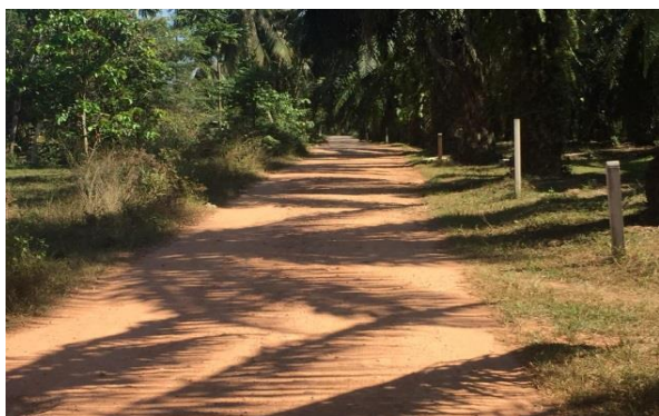
๙.โครงการก่อสร้างถนนคสล.สายยุทธศาสตร์ ม.๖- ม.๓ ภาพก่อนดำเนินการ
