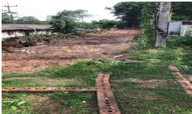
๒๒.โครงการบุกเบิกถนนลูกรังสายไสต่อ ม.๖ ภาพก่อนดำเนินการ
