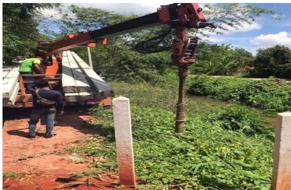
๒๔.โครงการขยายเขตไฟฟ้าแรงต่ำ (บ้านปากท่อ ม.๔) ภาพก่อนดำเนินการ
