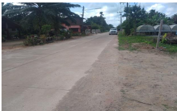
๘.โครงการก่อสร้างระบายน้ำถนนสายบ้านปากท่อ ม.๔ ภาพก่อนดำเนินการ
