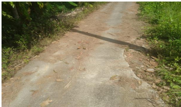
๗.โครงการซ่อมแซมถนน คสล.สายบ้านนายปรีชา ม.๕ ภาพก่อนดำเนินการ
